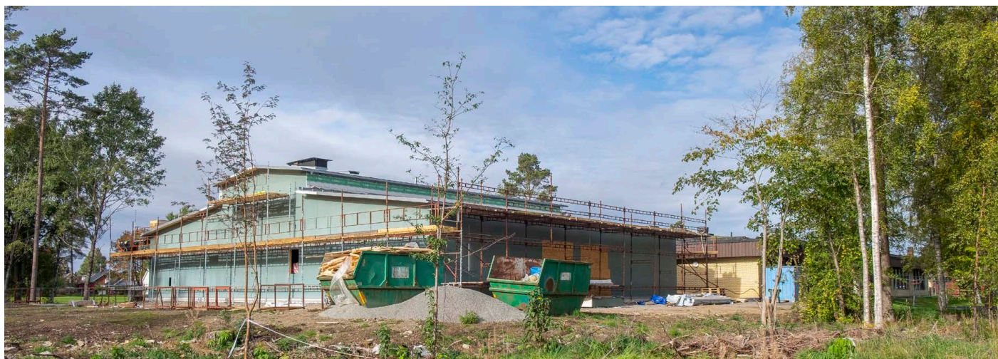
Pågående tillbyggnad av Hägneskolan, oktober 2018.
