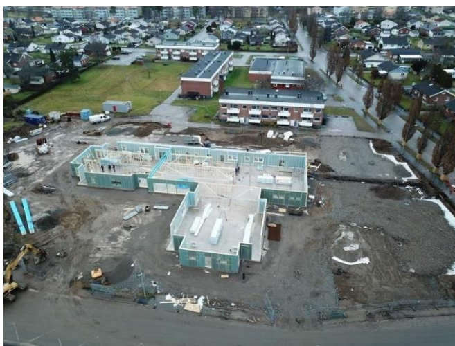
Bild: Förskolan Ripan tar form som Sävebo AB bygger
