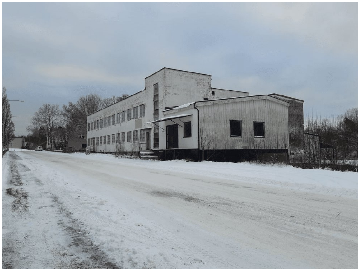
Figur 3: Bilden visar den befintliga gamla fabriken som står där idag.
