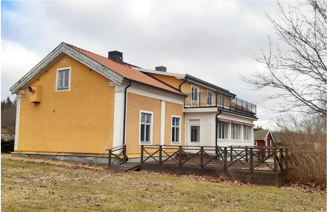
På bild: Fasad mot söder, 2024. Observera balkongräckena.
