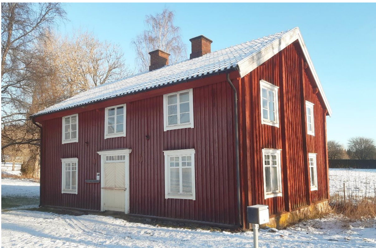
På bild: Arbetarbostaden, även benämnd som statarstugan. Notera fönsternas utformning.
